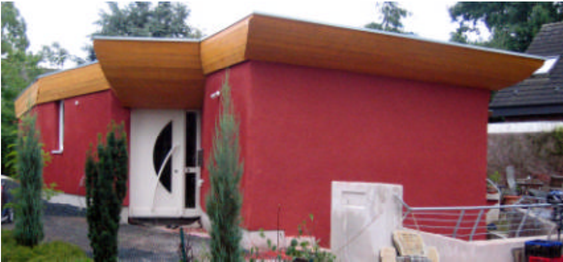
Eingangssituation, Nord – Weststrassenansicht
