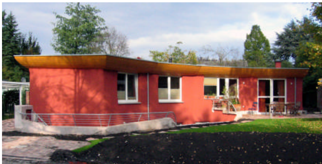
Gartenansicht mit Arbeitszimmer (links)
